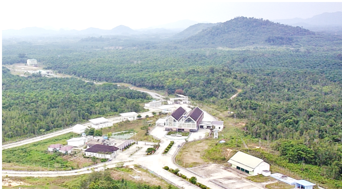
Gambar 1. Gedung Utama Pos Lintas Batas Negara (PLBN) Badau.
